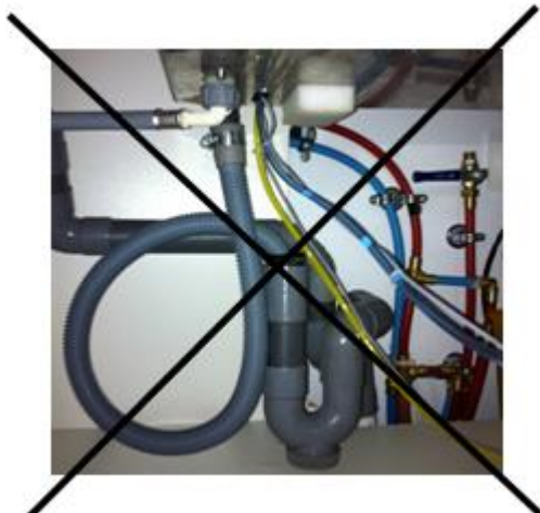
Raccordements NON CONFORMES
