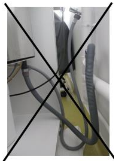
Raccordements NON CONFORMES
