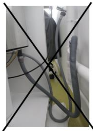
Raccordements NON CONFORMES
