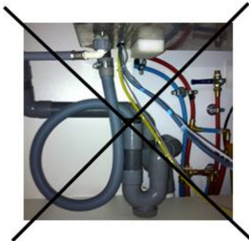
Raccordements NON CONFORMES
