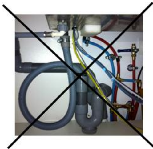
Raccordements NON CONFORMES
