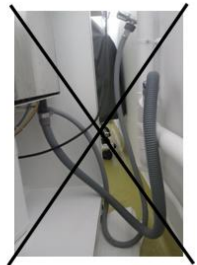
Raccordements NON CONFORMES
